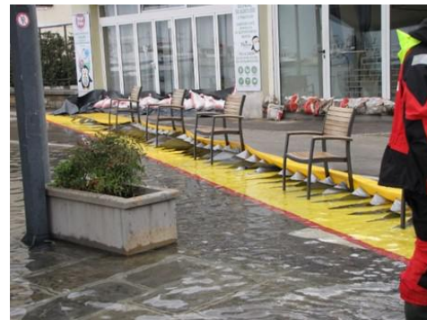
Protipoplavna pregrada za zaščito gostinskih lokalov na Sončnem nabrežju v Izoli ob visoki vodi 13. 11. 2019 (foto: Š. Guštin).
